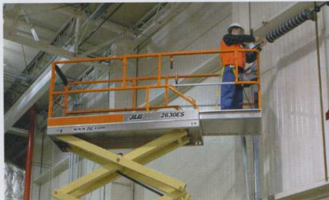
延長デッキで障害物越え作業
